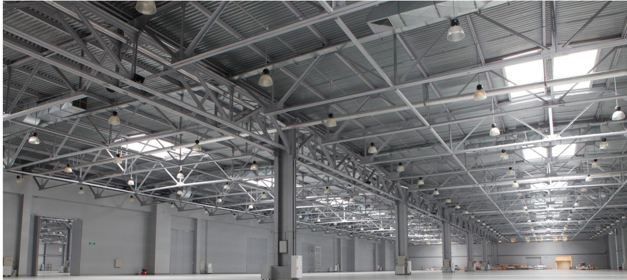
**07** Realizamos la actualización de la iluminación convencional a iluminación LED en una tienda comercial de 200 m<sup>2</sup> en Ensenada para mejorar la eficiencia energética y reducir costos
